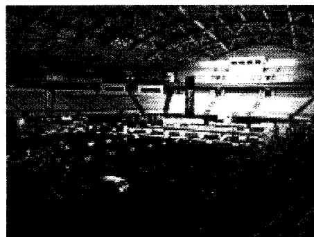
Hala położona na byłych terenach EXPO, nad zatoką
